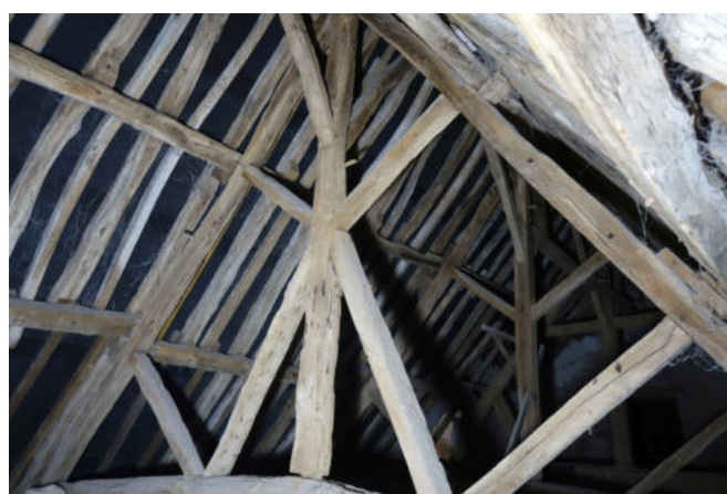
Fig. 52 : Seconde ferme de type 2 (la plus orientale)
