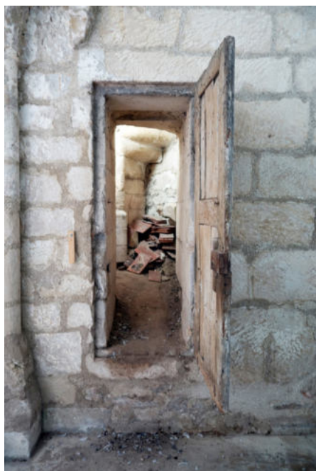
Fig. 37 : Porte donnant accès à l'escalier logé dans la tourelle permettant d'accéder aux charpentes de l'église
