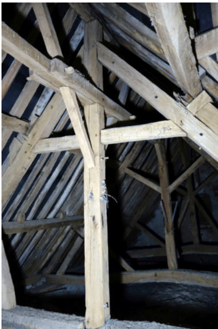
Fig. 47 : Première ferme (type 1) de la charpente du chœur au premier plan et les deux fermes (type 2) à l'arrière-plan
