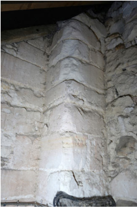
Fig. 59 : Contrefort intégré à la maçonnerie de la chapelle Saint-Joseph au sud de l'église
