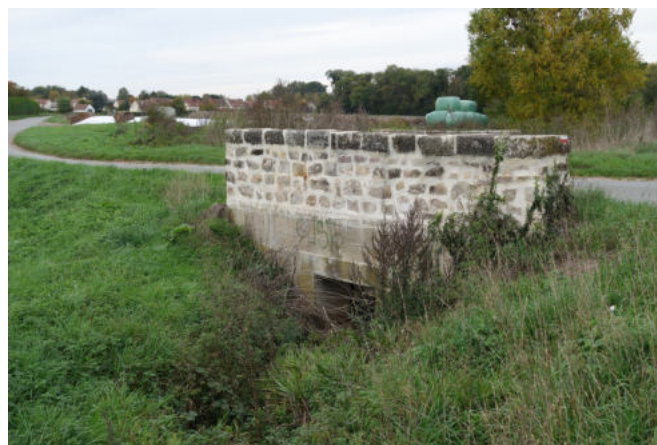
Fig. 108 : Pont sur la Thève
