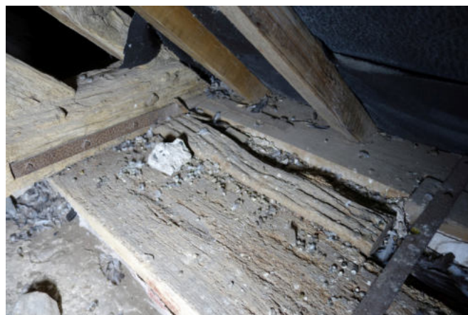
Fig. 54 : Détail des sablières récentes intégrant la sablière ancienne (au niveau de la seconde ferme de type 2)
