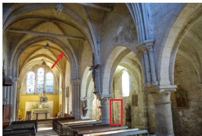
Fig. 40 : Localisation de la porte d'accès aux combles et de l'arc-diaphragme entre la nef et le chœur
