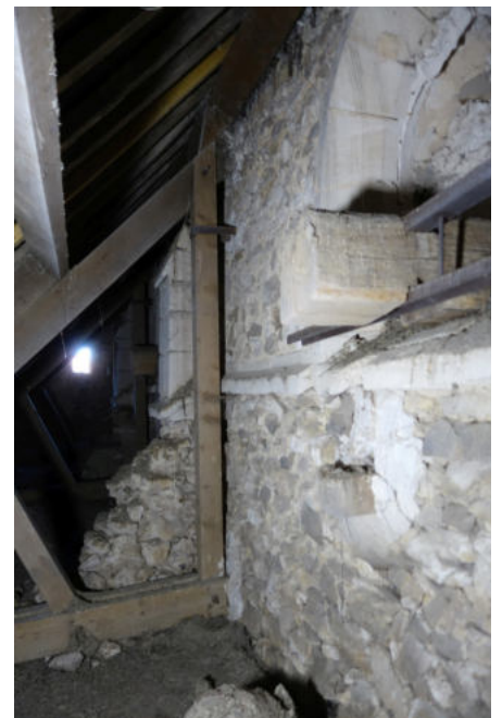
Fig. 62 : Bas-côté sud vu depuis l'est avec ses baies, contreforts et tirants
