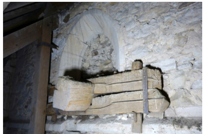
Fig. 66 : Détail d'un tirant retenu par une pièce moisée à clavettes dans le comble du bas-côté sud
