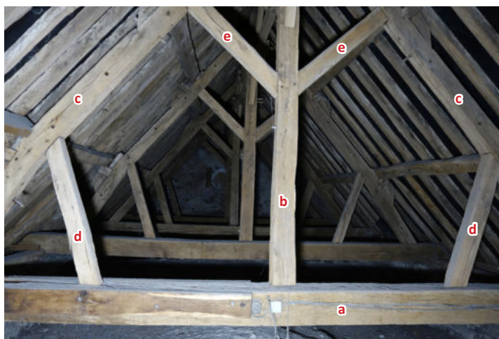
Fig. 42 : Charpente du chœur avec identification des pièces d'une ferme : entrait (a), poinçon de fond (b), arbalétriers (c), jambettes (d), contrefiches (e)
