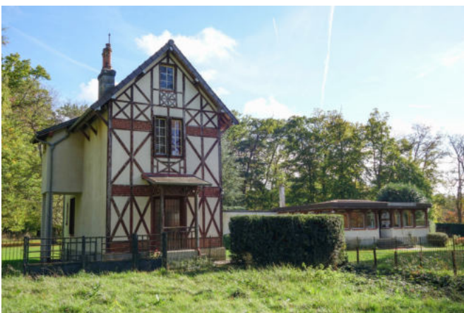
Fig. 79 : Maison (de gardien ?) à l'entrée nord de l'ermitage
