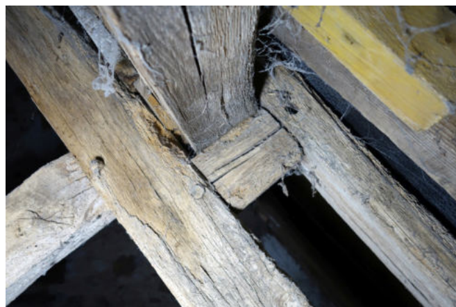
Fig. 50 : Détail de l'entretoise reliant l'arbalétrier au chevron des fermes de type 2
