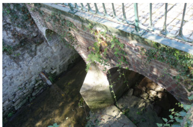
Fig. 105 : Vue amont du pont sur la Launette
