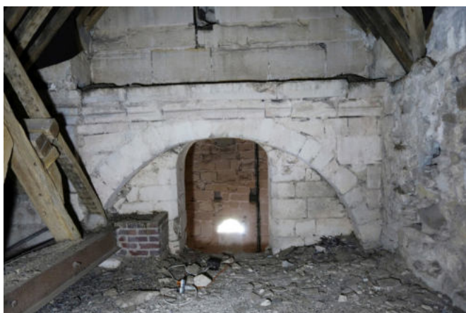
Fig. 39 : Vue de la porte d'accès aux combles de la nef et du chœur depuis le comble (vers le sud)
