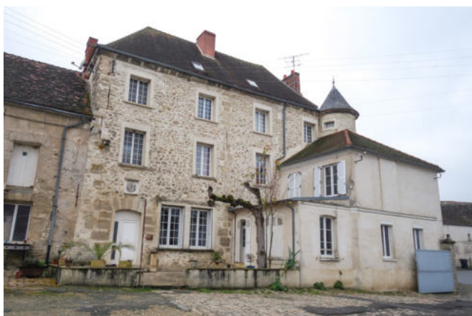
Fig. 94 : Façade sur cour du logis de la ferme du Château
