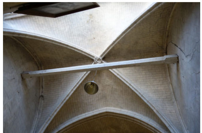
Fig. 67 : Tirant visible dans la nef
