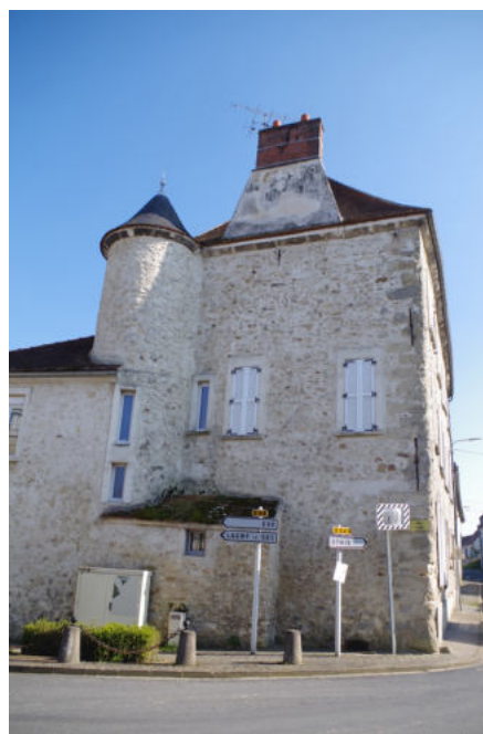
Fig. 93 : Mur-pignon nord du logis de la ferme du Château avec sa tourelle d'escalier
