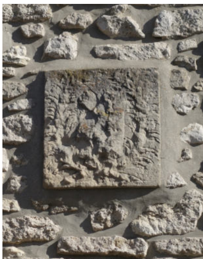
Fig. 99 : Bloc décoré d'un blason bûché en réemploi dans la façade sur cour de l'habitation
