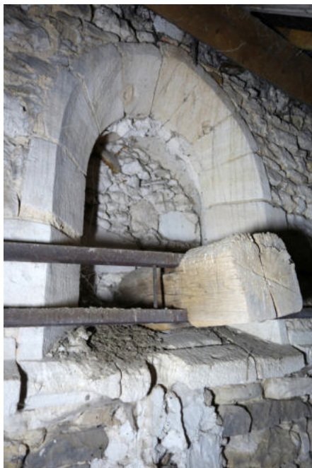
Fig. 64 : Détail de la baie bouchée et du tirant bloqué par des poutrelles IPN dans le comble du bas-côté sud
