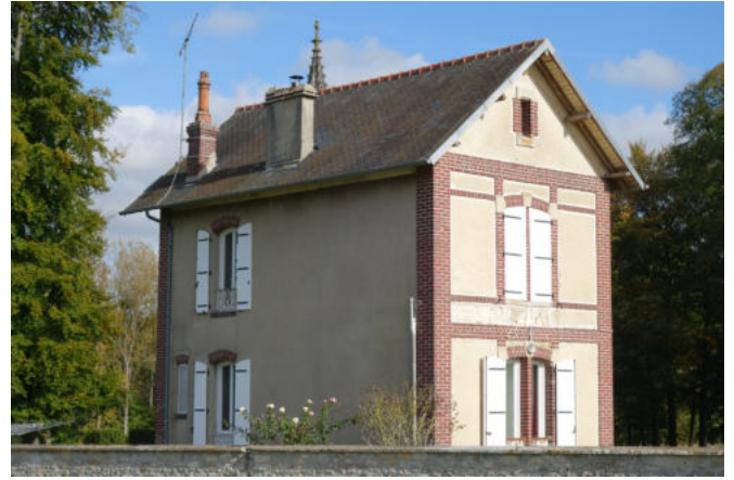
Fig. 74 : Maison de gardien à l'entrée sud de l'ermitage
