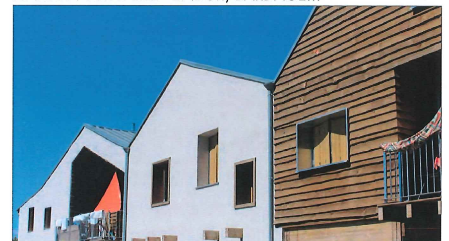
FINITION SUR PAILLE - ENDUIT, BARDAGE...
