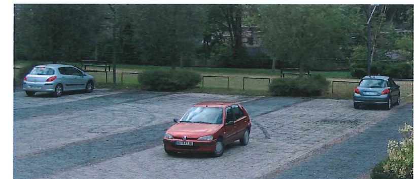
PARKING : Revêtement de sol perméable (dalles alvéolaires enherbées ou remplissage en gravillon)
