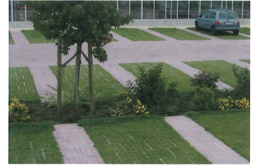
PARKING : Revêtement de sol perméable (dalles alvéolaires enherbées ou remplissage en gravillon)
